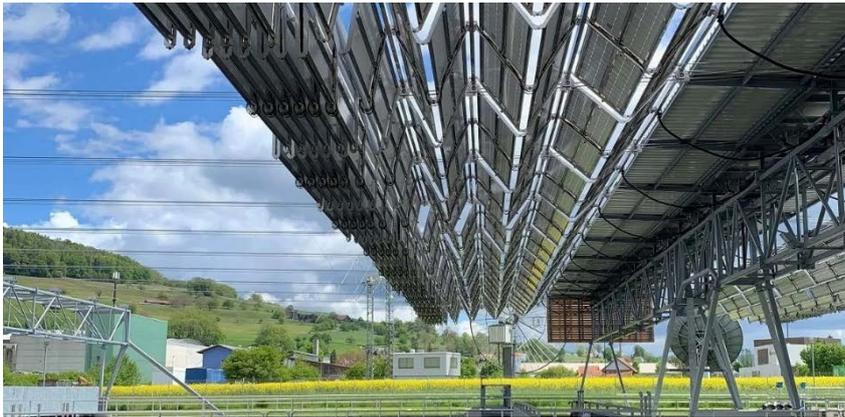
Abb. 29: Photovoltaikfaldach von dhp technology AG (dhp technology AG, online)
